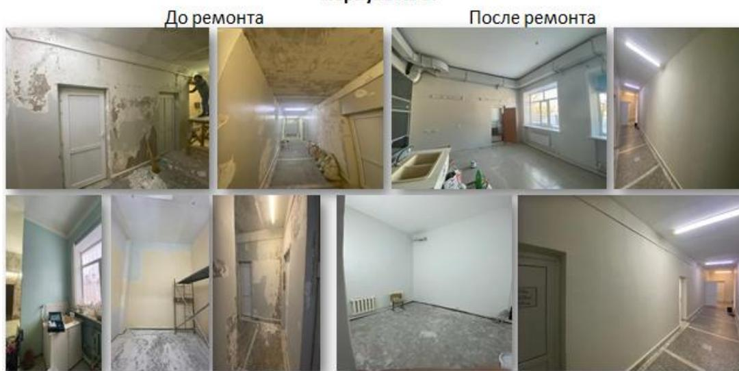
В учебном корпусе № 8 проведен текущий ремонт Творческого центра «Balausa» с отделкой помещений с полным циклом электромонтажных и сантехнических работ, включая отопление.
