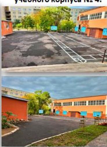
Текущий ремонт асфальтового покрытия плаца на территории учебного корпуса № 4.
